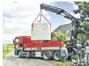
Die Firma Witt versetzt fugenlose Betonbehälter in eine Baugrube.
