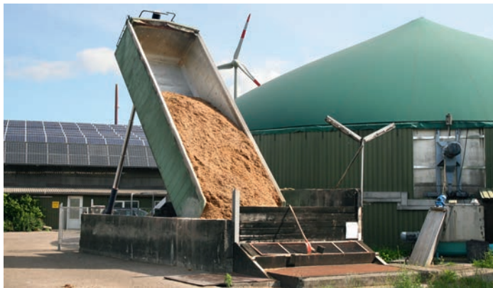
Da Biogas als einzige Erneuerbare Energie speicherbar ist, kann damit die schwankende Produktion von Wind- und Solarstrom reguliert werden.
